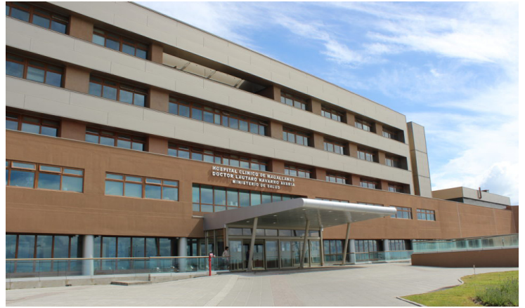
En el Hospital Clínico de Magallanes falleció el trabajador luego de sufrir la caída de altura.
