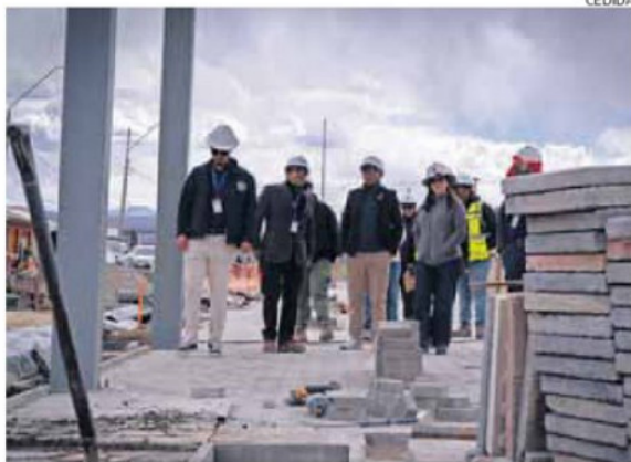
SEREMI DEL MINVU VERIFICÓ AVANCE DE LAS OBRAS EN OLLAGÜE.
