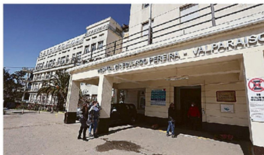
EL HOSPITAL EDUARDO PEREIRA INCORPORARÁ UN ANGIÓGRAFO.
