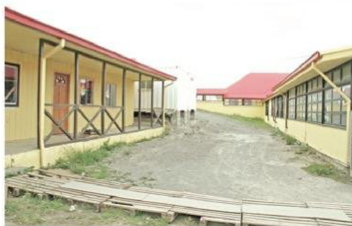
La Escuela Bernardo O'Higgins está llena de "parches", como el inmueble a la izquierda, que era parte de las instalaciones de la antigua estancia Caleta Josefina, desarmado y reconstruido en el patio del plantel para las clases de música.
