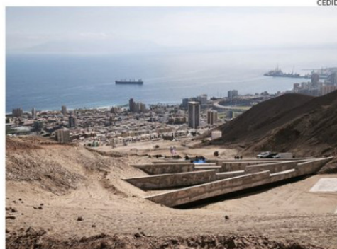
NUEVA INFRAESTRUCTURA REFORZARÁ SEGURIDAD ALUVIONAL.
