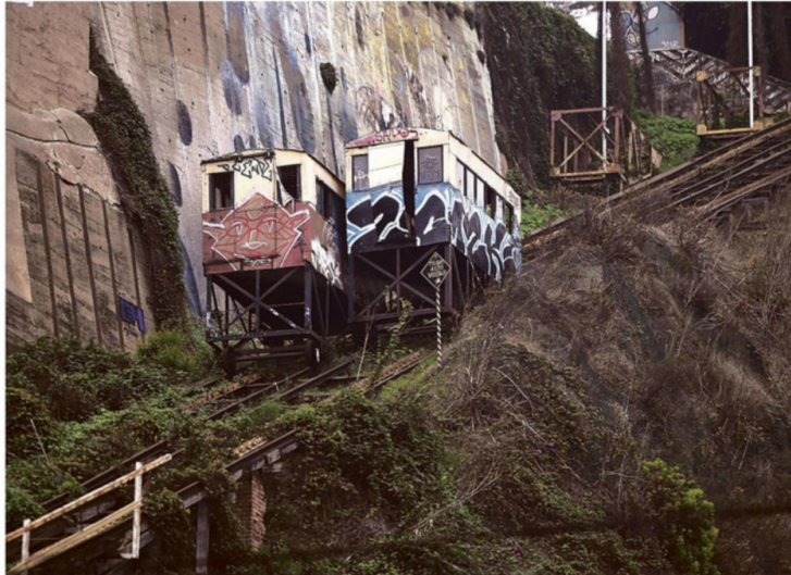
CONSULTORÍA SE ENFOCÓ EN EL SISTEMA ELECTROMECAÁNICO Y EL PLANO DE RODADURA DE ARTILLERÍA.
