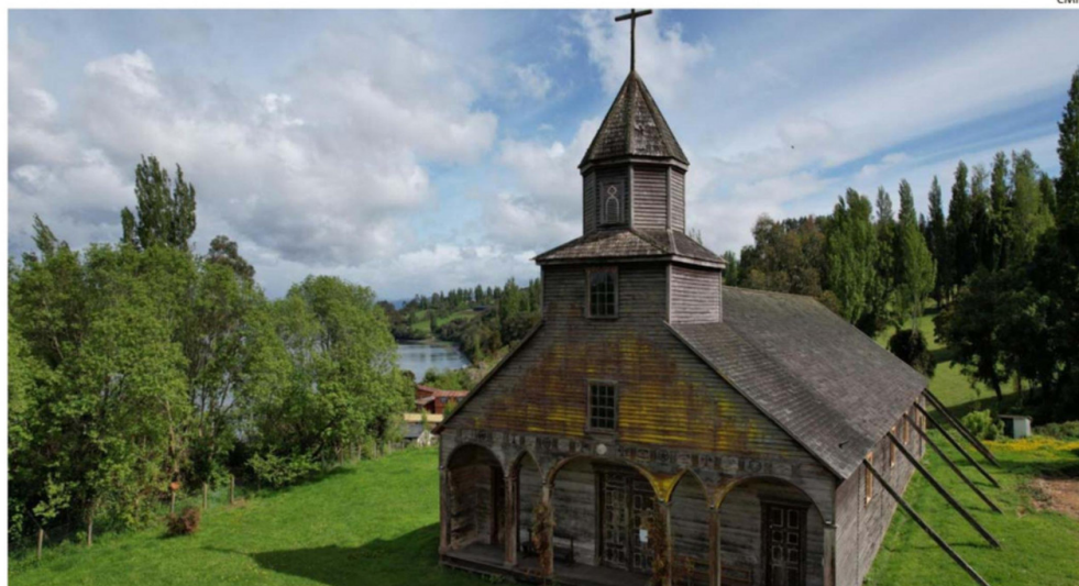
APARTE DE CAMBIAR LO PUNTALES QUE CUMPLIERON MÁS DE DOS DÉCADAS Y OTRAS FAENAS, SE REQUIERE UNA RESTAURACIÓN MAYOR DEL TEMPLO QUE DATA DEL SIGLO XIX.
