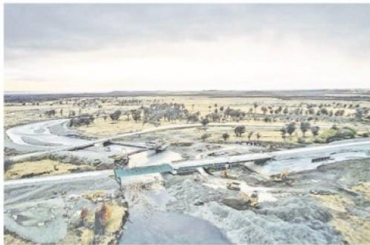
La construcción del puente sobre el río Rubens, en la provincia Última Esperanza.
