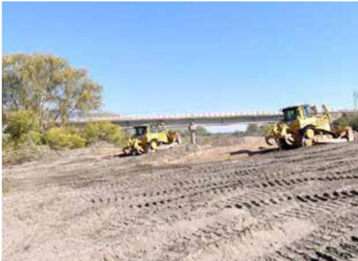
Trabajos se han concentrado en despejar los islotes en medio del río en varios sectores.
