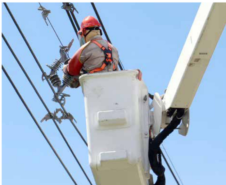
De los 22.000 mil clientes afectados, hubo 5.000 que permanecieron más de 12 horas sin energía eléctrica.
