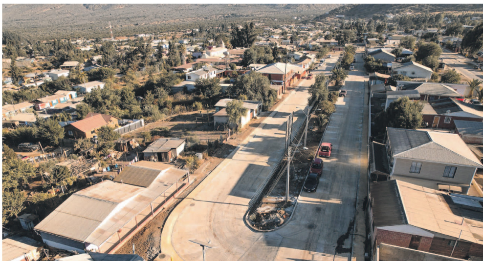
La ejecución de las obras de alcantarillado de Caimanes en Los Vilos comenzó oficialmente en 2024, tras 20 años de espera.
