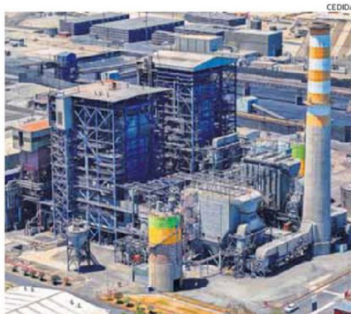
PROYECTO SE UBICA EN EL ÁREA INDUSTRIAL DEL PUERTO DE MEJILLONES.
