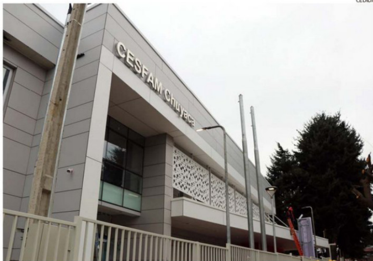
EL TÉRMINO DE LAS OBRAS DEL CESFAM DE CHUYACA ESTÁN PROGRAMADAS PARA EL PRÓXIMO 30 DE JUNIO.
