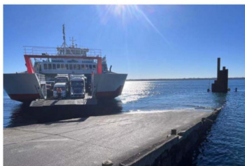
TRABAJOS EN EL TERMINAL PORTUARIO LLEVAN 35% DE AVANCE.
