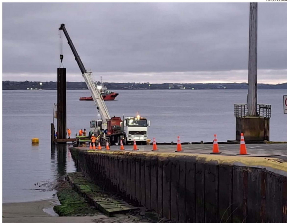
DURANTE LOS DÍAS DE RESTRICCIÓN SE TRABAJARÁ EN PERÍODOS DE BAJA MAREA EN EL ACCESO NORTE A CHILOÉ.
