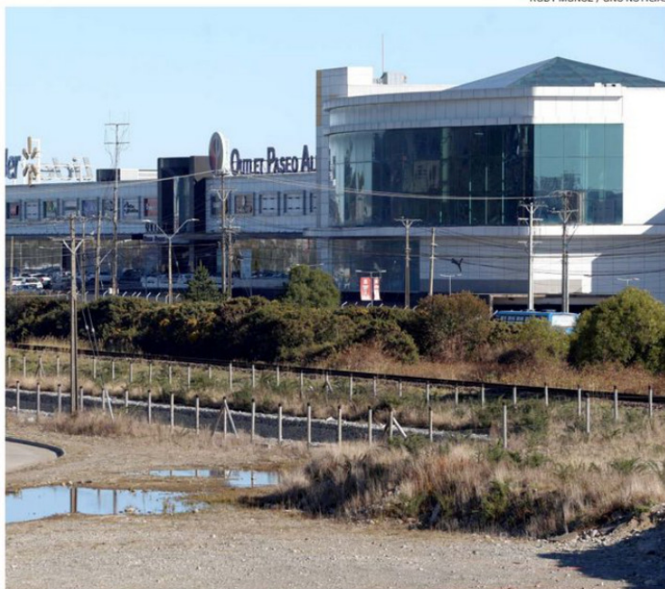
LA ESTRUCTURA DE ENLACE EN ALTURA ESTÁ PROYECTADA FRENTE AL OUTLET ALERCE DEL GRUPO PASMAR.
