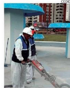
TRABAJOS EN PILETA SECTOR SUR.
