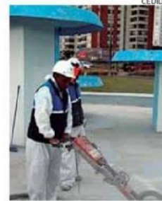
TRABAJOS EN PILETA SECTOR SUR.
