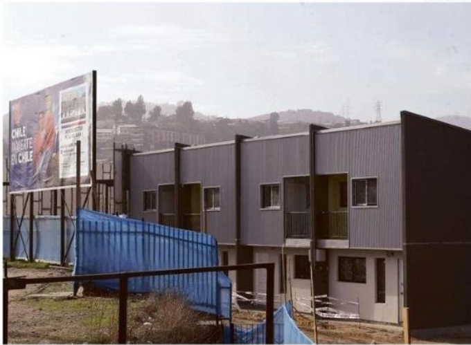
ESTÁ CONFIRMADO EL DESMANTELAMIENTO DE 56 VIVIENDAS DE EMERGENCIA EN EL SECTOR.
