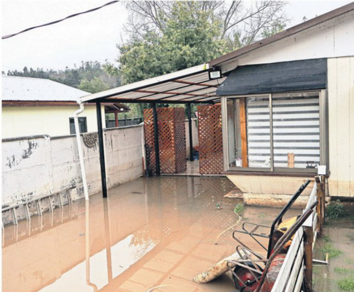
DESDE EL 2023 QUE LOS VECINOS DE SANTA RITA SE VIENEN INUNDANDO POR CULPA DEL ANDALIÉN.
