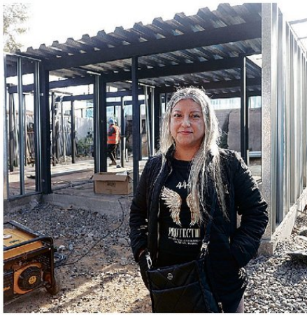
PRISCILA BARRA, DAMNIFICADA, RESPALDÓ LA DEMOLICIÓN DE LAS OBRAS.
