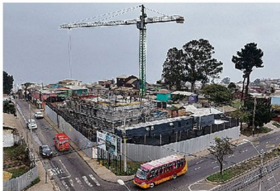
LA TENENCIA DE PLAYA ANCHA CUENTA CON UN 38 % DE AVANCE.
