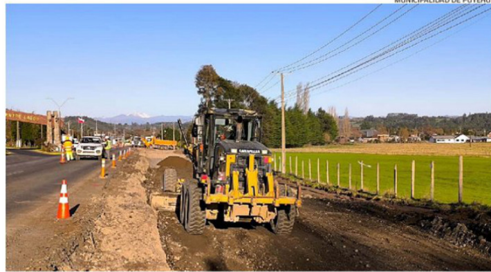
EN DISTINTOS PUNTOS DE LA VÍA SE REALIZAN TRABAJOS, POR LO QUE ES NECESARIO CONducIR CON PRECAUCIÓN.
