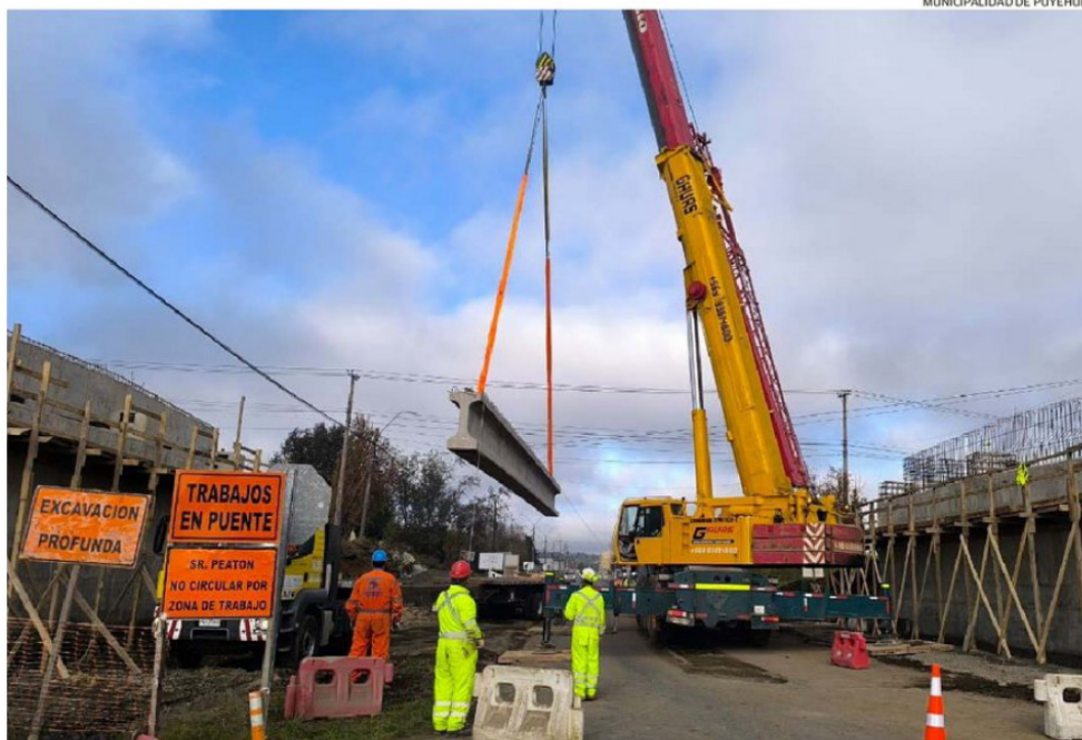
LA INSTALACIÓN DE LAS VIGAS EN EL PUENTE SECO FUE UN IMPORTANTE AVANCE QUE SE CONCRETÓ EL MARTES 19 DE MAYO.
