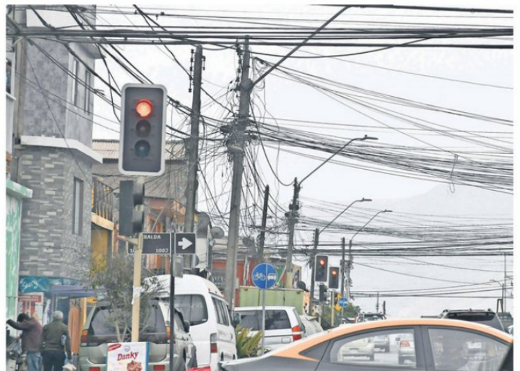
EN IQUIQUE SE INICIARÁ LA PRIMERA ETAPA DE RETIRO
