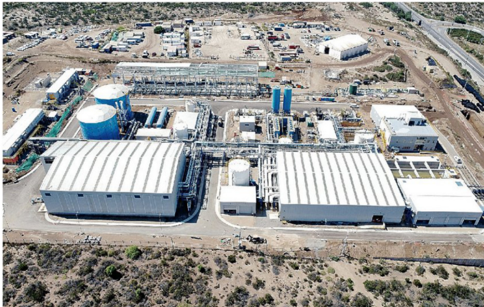
LA PLANTA MULTIPROPÓSITO QUE AGUAS PACÍFICO DESARROLLA EN PUCHUNCAVÍ.
