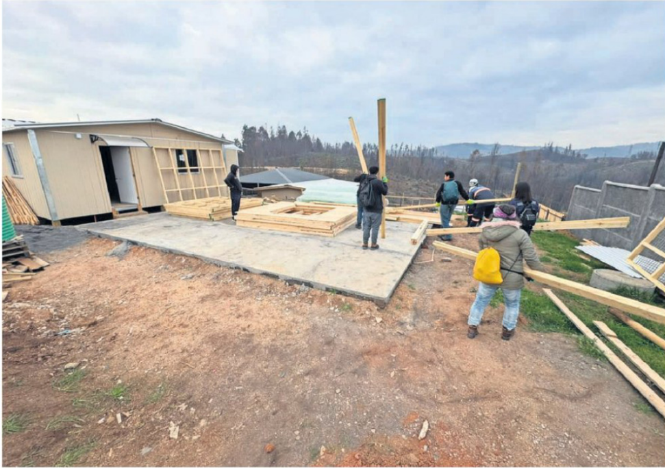
El proceso de instalación se concretó con apoyo de voluntarios y de la Defensa Civil.
