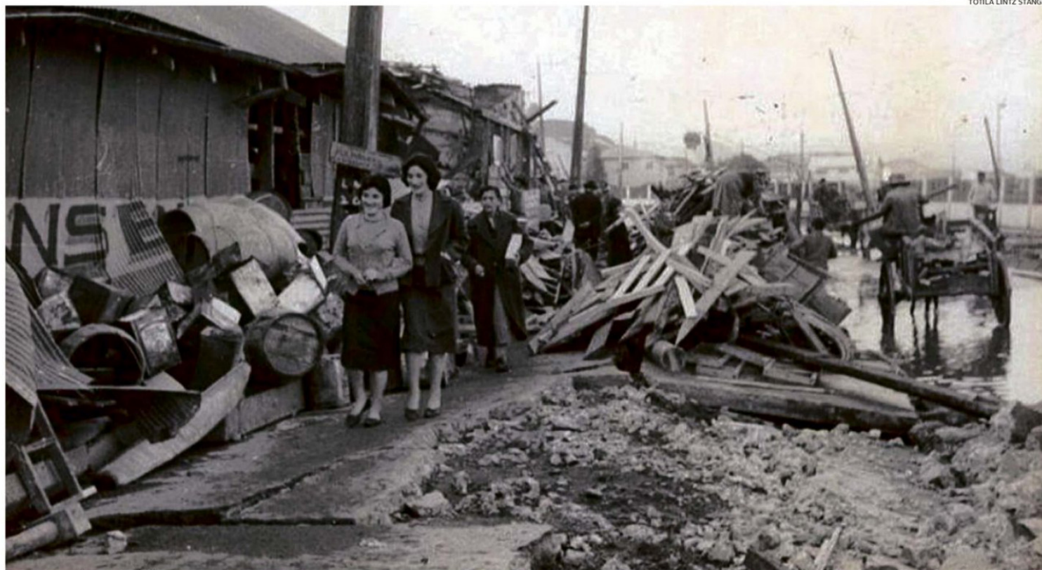
GRAN AFECTACIÓN HUBO EN DIVERSAS CONSTRUCCIONES DE PUERTO MONTT TRAS EL TERREMOTO. NO EXISTIERON DAÑOS PRODUCTO DEL MAREMOTO, QUE NO SE MANIFESTÓ EN EL SENO DEL RELONCAVÍ.
