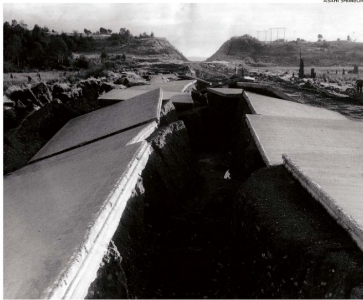
EL ESTADO DE UNA CARRETERA DE PUERTO MONTT REFLEJA LA INTENSIDAD DEL MOVIMIENTO SÍSMICO.
