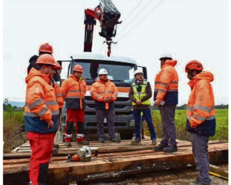
SEREMI UISES RIVERA REALIZÓ UNA VISITA INSPECTIVA A LAS OBRAS QUE SE REALIZAN EN LOS PUENTES.
