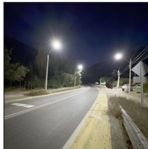
Instalan luminarias en Camino Internacional.
