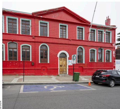
El edificio de Balmaceda 736, el primero que Hogar de Cristo adquirió en la región en 1985.
