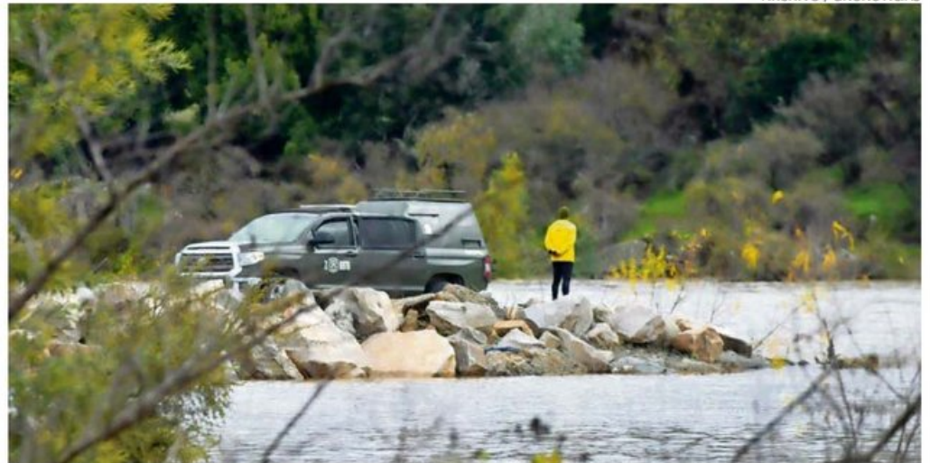
La patente estaba en el sector norte del cauce. En la zona se trabaja con maquinaria.
