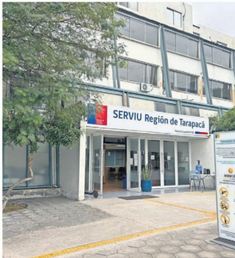
HOY CORROBORARÁN SI SUBSANARON LAS DEFICIENCIAS DETECTADAS.
