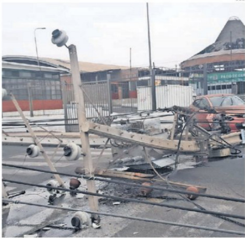
EL IMPACTO DAÑÓ AL TRANSFORMADOR Y OCHO POSTES.
