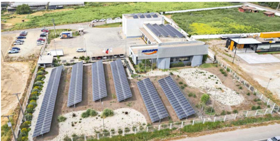
Cada nuevo proyecto contará con 620 paneles solares destinados principalmente al autoabastecimiento energético.
