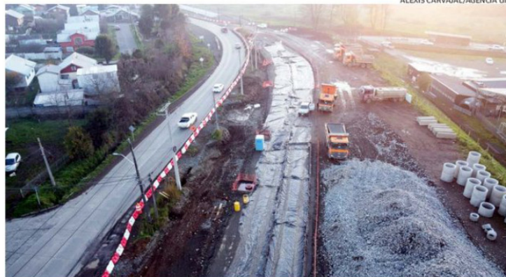
EN LA IMAGEN SE APRECIA EL AVANCE DE LAS OBRAS DE LA DOBLE VÍA EN EL ACCESO NORTE POR PILAUCO.
