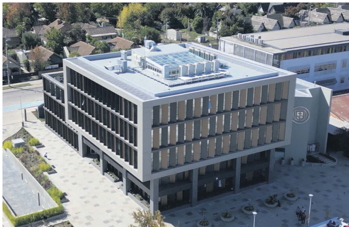
Edificio Facultad de Ciencias Básicas, que alojará al Planetario, recientemente aprobado por el GORE Maule, con una inversión superior a los 3.500 millones de pesos.
