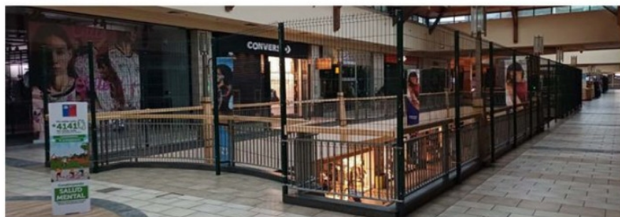
EN UNA SEGUNDA ETAPA SE CAMBIARÁN ESTAS BARRERAS METÁLICAS POR CRISTAL TEMPLADO.
