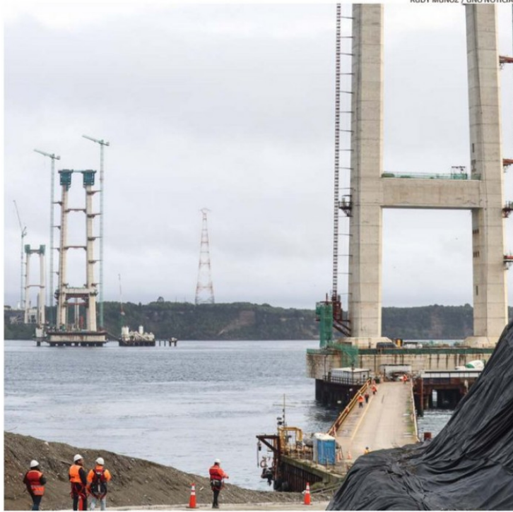
CONTEMPLA LA CONSTRUCCIÓN DE UNA PASARELA A 200 METROS SOBRE EL MAR PARA INSTALAR EL CABLEADO.
