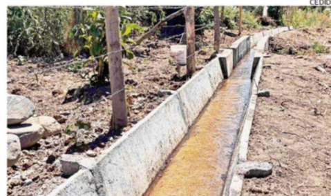
NUEVE CANALES SERÁN INTERVENIDOS PARA FORTALECER LA SEGURIDAD HÍDRICA EN ÑUBLE.
