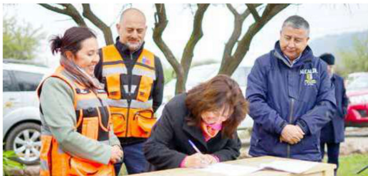
En la localidad de Quinta El Alto, autoridades y vecinos se reunieron para participar en el inicio de trabajos de conservación en la ruta J-120.
