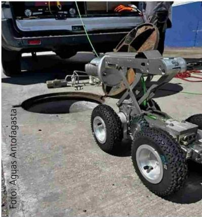
Equipo de teleinspección usado para detectar fugas en las redes de agua potable.
