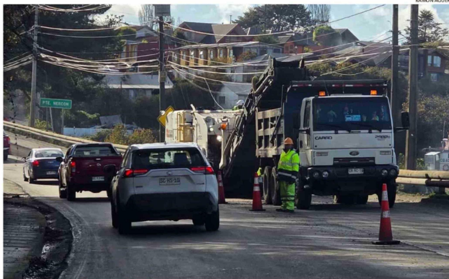
EN EL SECTOR DEL PUENTE DE NERCÓN SE ESTÁN EJECUTANDO TRABAJOS EN LA RUTA 5 SUR.
