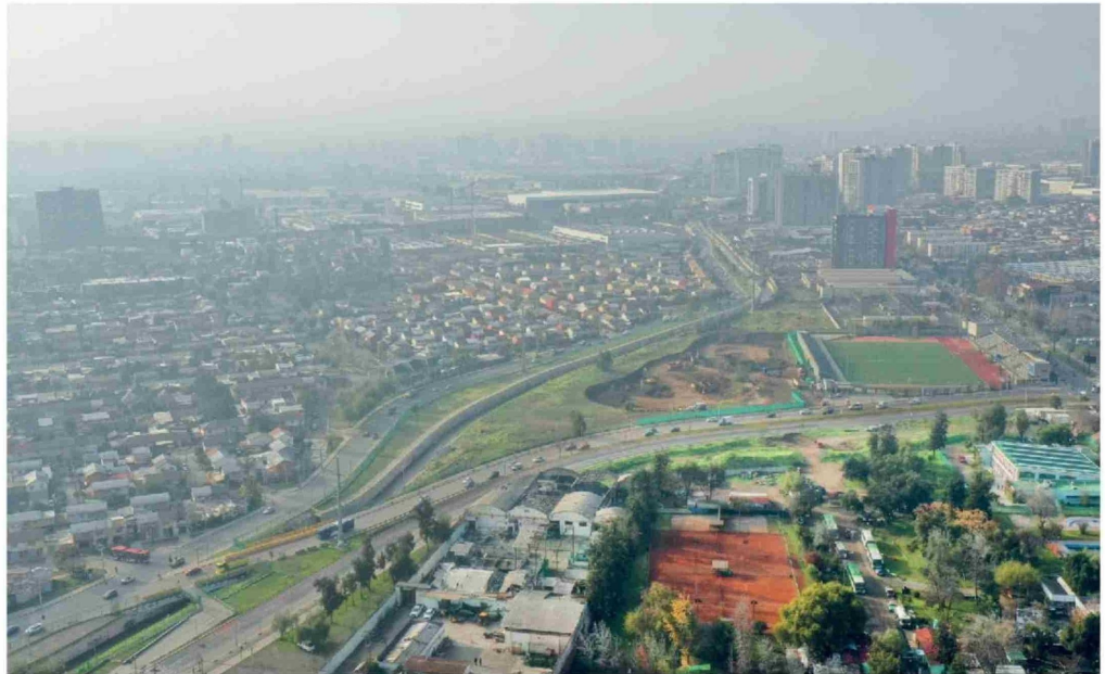
El objetivo del Parque Inundable Víctor Jara es contener y regular la crecida del Zanjón de la Aguada en caso de que existan lluvias intensas, evitando así su desborde. Foto: MOP.
