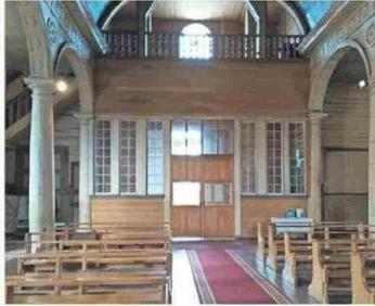
tura religiosa, valorado a nivel global. Se edificaron en madera -principal material de construcción en islas cubiertas de bosques- con piezas unidas portarugos y cuñas de madera. Este singular sistema, con ejemplos notables como la iglesia de Achao que no tiene clavos, se explica por la destreza de los artesanos huilliches, quienes utilizaban las mismas técnicas que empleaban para construir sus dalcas o embarcaciones y según el diseño de los misioneros jesuitas que ha-
