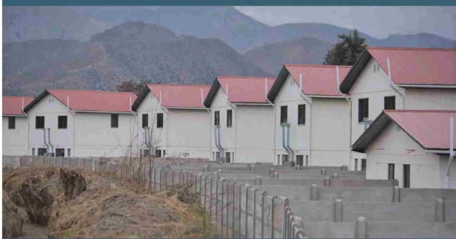
Son 82 nuevas casas para disminuir el déficit habitacional que existe en la comuna
