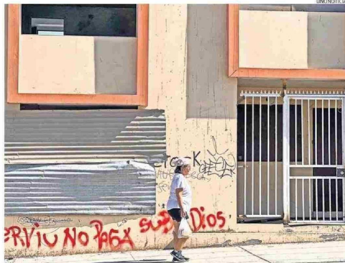
ACTUALMENTE EL CONJUNTO HABITACIONAL SE ENCUENTRA ABANDONADO Y CON DECRETO DE DEMOLICIÓN.
