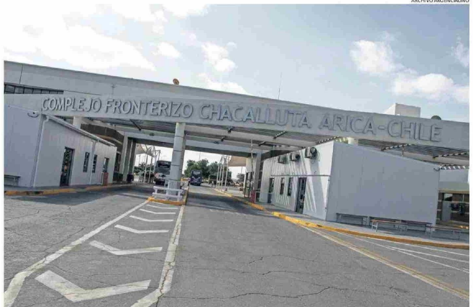
ASÍ LUCE HOY EL COMPLEJO FRONTERIZO CHACALLUTA, A LA ESPERA DE SU TAN ANHELAGADA CONSERVACIÓN Y MODERNIZACIÓN.
