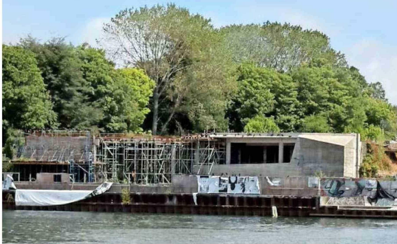
Obras paralizadas MAC Valdivia, febrero 2026.
