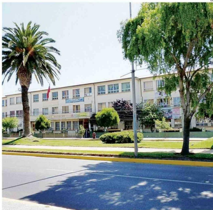
LAS DOS ESCUELAS COMPARTEN EL EDIFICIO UBICADO FRENTE A LA PLAZA DE BARRANCAS.
