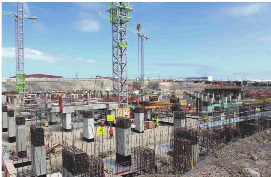
El nuevo hospital de Coquimbo avanza en su construcción y se espera que entre en operación en el año 2028. Las obras las realiza la empresa China Railway Construction Corporation.
